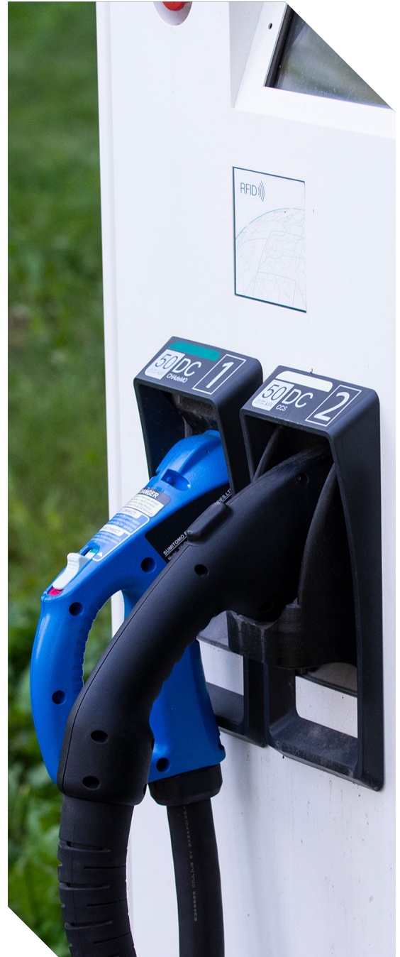
Deux bornes de recharge rapide à courant continu
